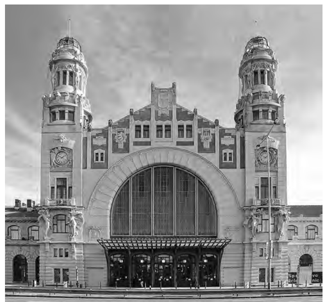
Josef Fanta, průčelí budovy Hlavního nádraží v Praze
